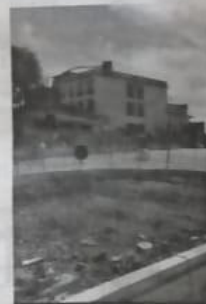
Il cantiere di S. Leucio
